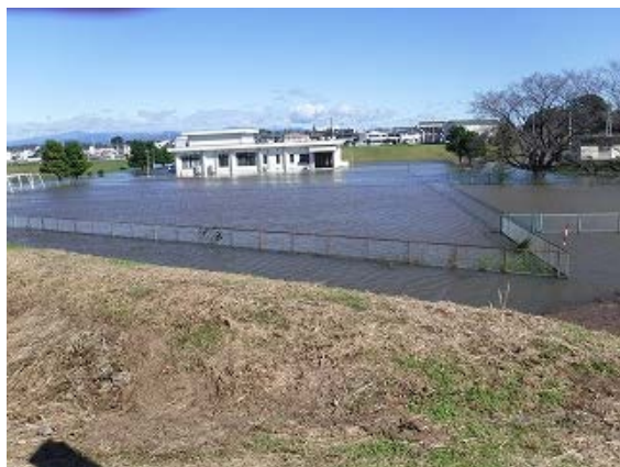
図 令和元年東日本台風における 大泉第二浄水場の浸水被害状況
