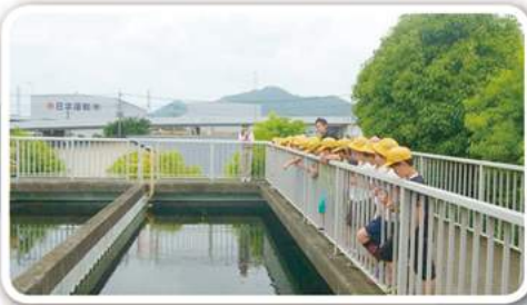
渡良瀬浄水場 (太田市)
