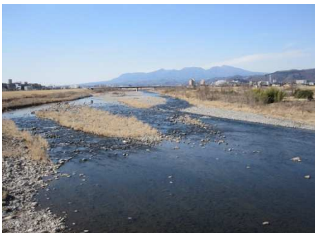
渡良瀬川 (渡良瀬浄水場取水口付近)
