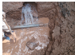
老朽化した管路の漏水
