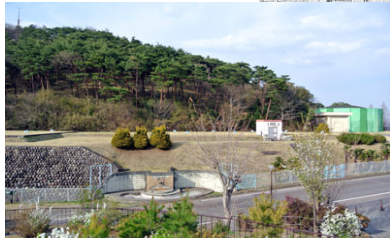
太田金山配水池【近景】
