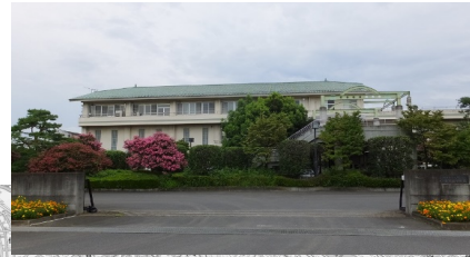
太田渡良瀬浄水場
