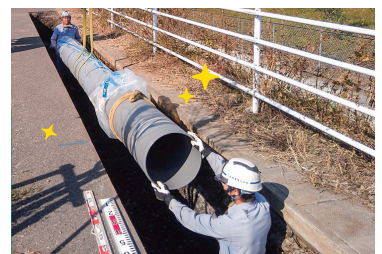
新しい水道管
