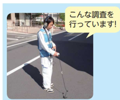
図 5-5 漏水調査の様子
