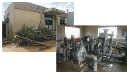
平成30年西日本豪雨で冠水した浄水場
