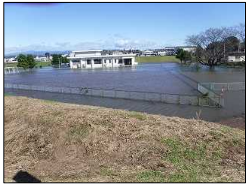
図 3-4 大泉第二浄水場の浸水被害状況
