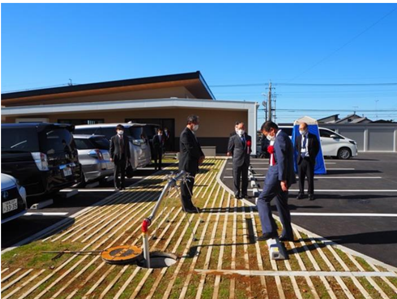
災害用緊急給水設備
