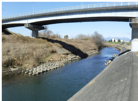
石田川（利根川支川） （古利根橋付近）
